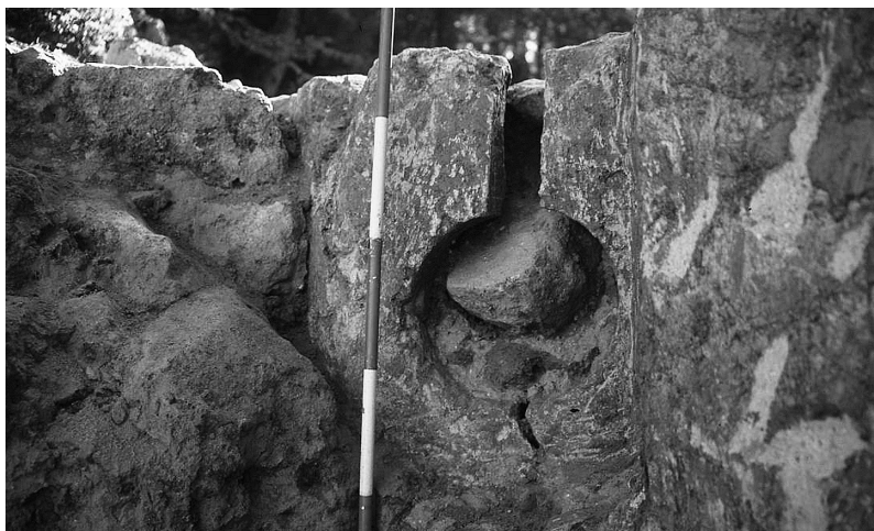
Sl. 7: Ohranjena strelna lina v temeljih stolpa
