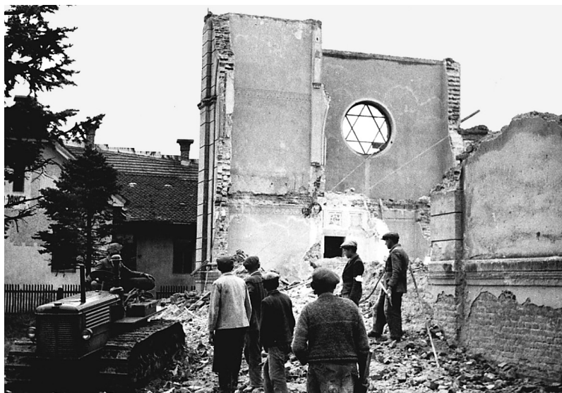
Rušitev sinagoge leta 1954 / Demolition of the synagogue in year 1954 (fotograf/photographer: Jože Kološa - Kološ)
