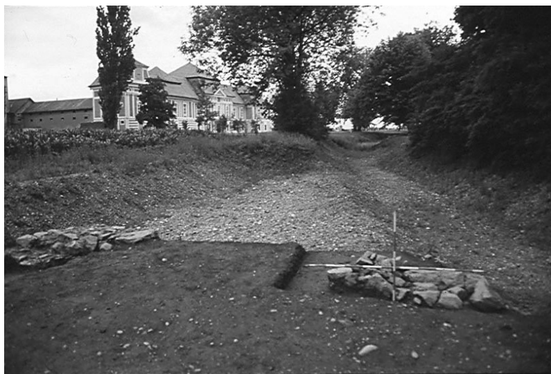
Sl. 1: Betnavski grad, pogled na izkopno polje s srednjeveškimi in novoveškimi gradbenimi ostalinami ob obnovitvenih delih vodnega jarka v grajskem parku.
